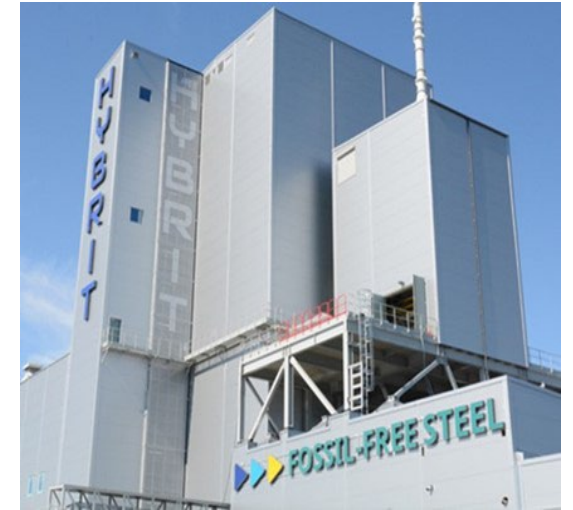
Hybrits pilotanläggning, vätgasbaserad reduktion, SSABs elektrifiering mha ljusbågsugn
